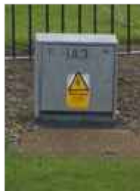
EXISTING MINI PILLAR
